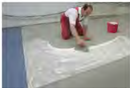
Нанесение клея
