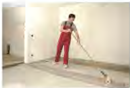
Грунтование стяжки
